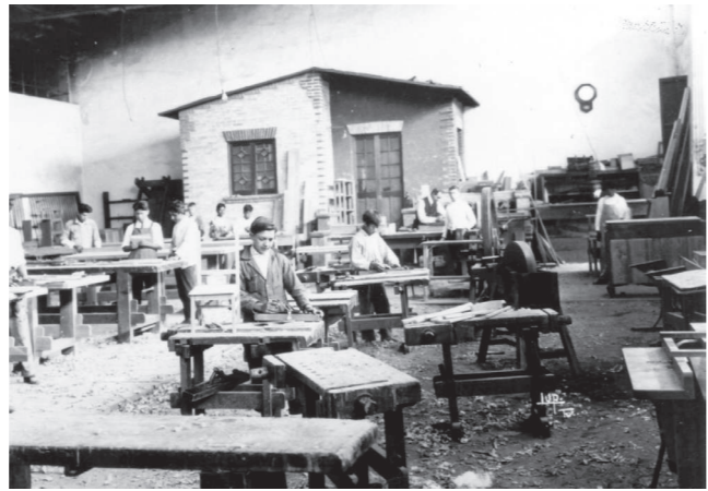
Escuela Técnica de Maestros Constructores.
